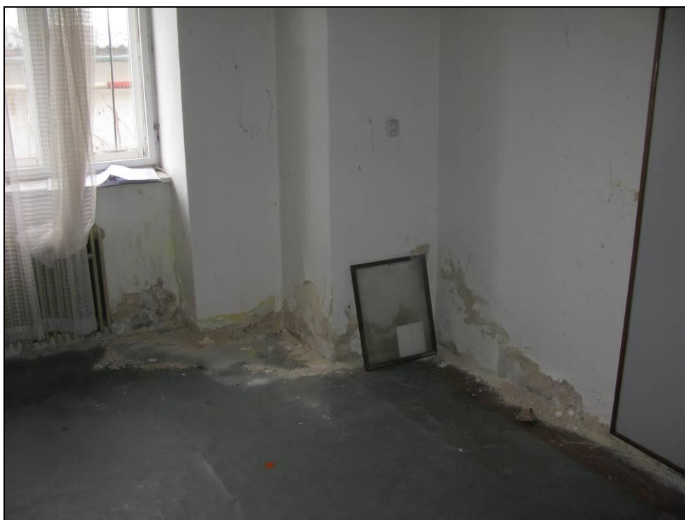
Obr. č. 11 - detailní pohled na opady omítky uvnitř kulturní místnosti vlivem vlhkosti a mrazu (v objektu se netopí).
