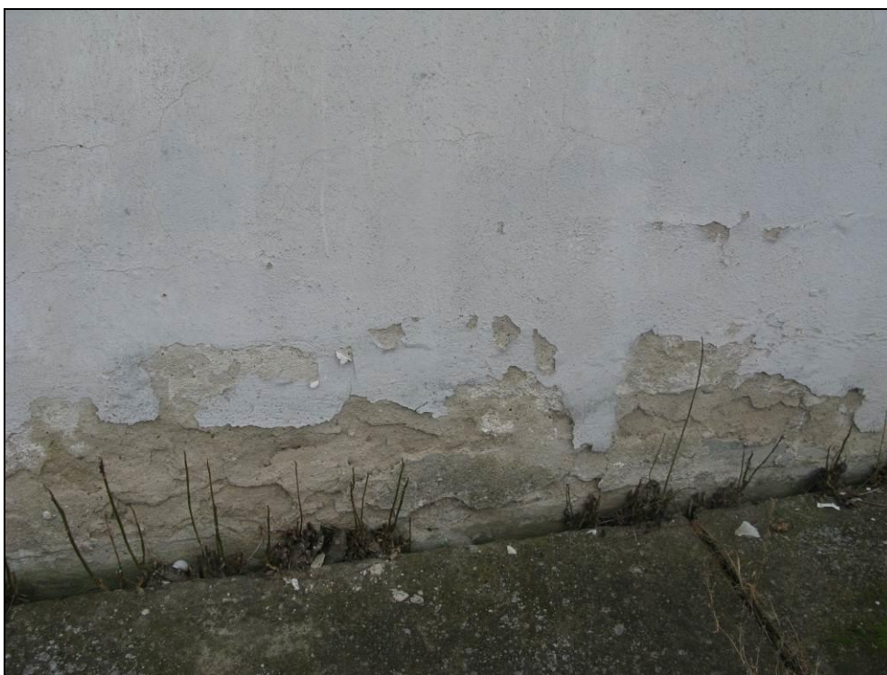
Obr. č. 10 - detailní pohled na opady omítky vnějšího líce objektu u kontaktu s terénem.
