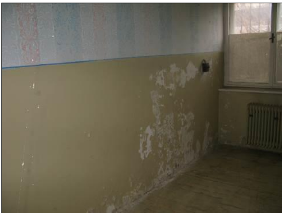
Obr. č. 12 - detailní pohled na opady omítky a nátěru uvnitř místnosti nocležny.
