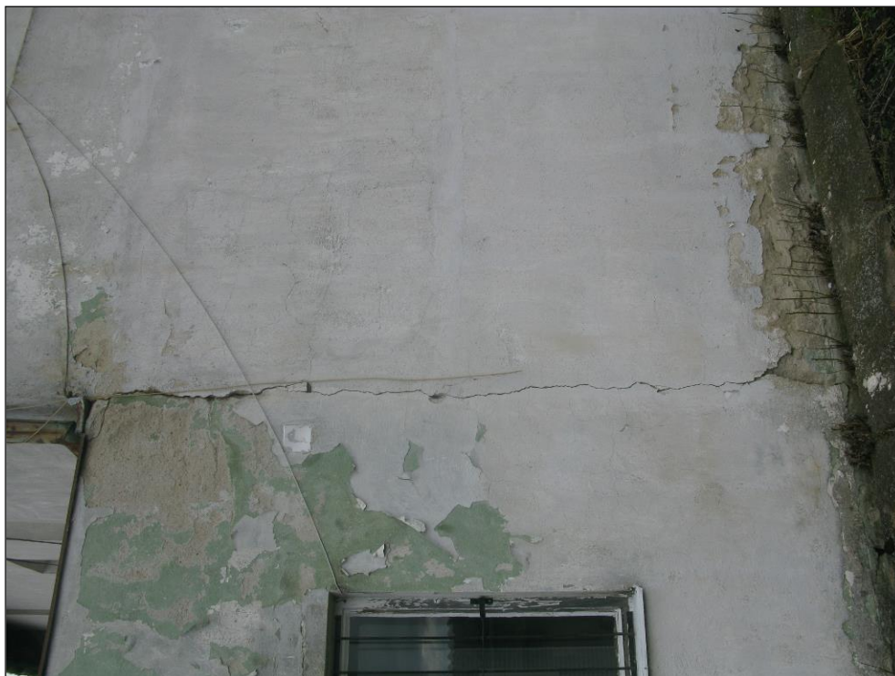
Obr. č. 9 - pohled na svislou trhlinu na kontaktu několikapodlažní budovy a severní přízemní přístavby.
